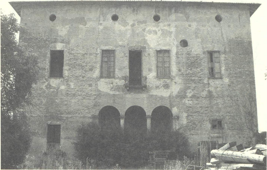
Fagnano: castello Borromeo, facciata.
