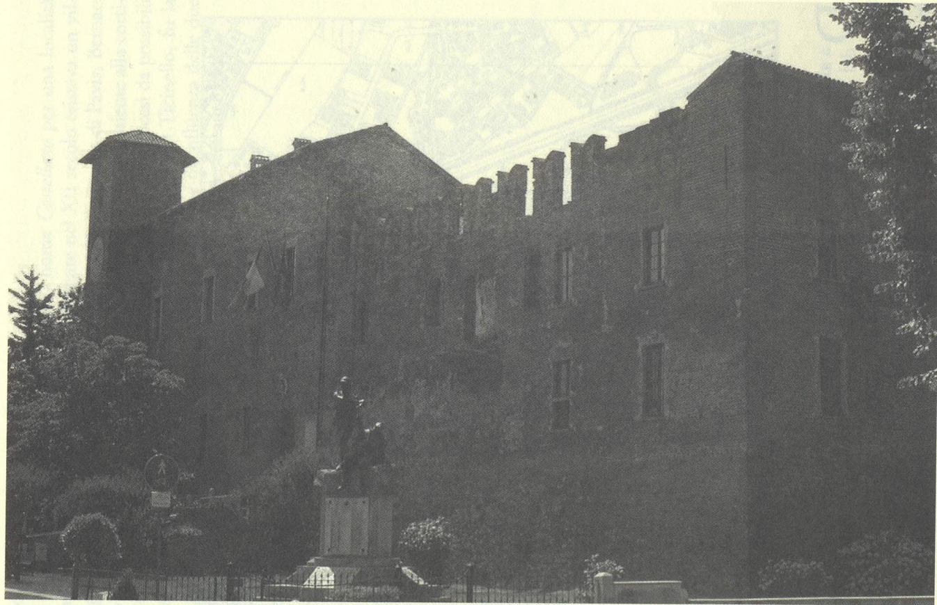
Binasco: castello visconteo sec. XIV.
