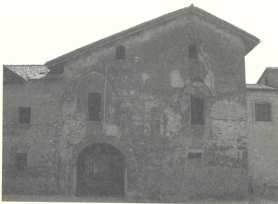
Locate: cascina Resentera sec. XIV, ingresso fortificato.
