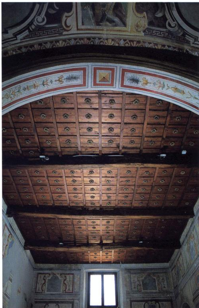
Fig. 9 - Soffitto della chiesa
