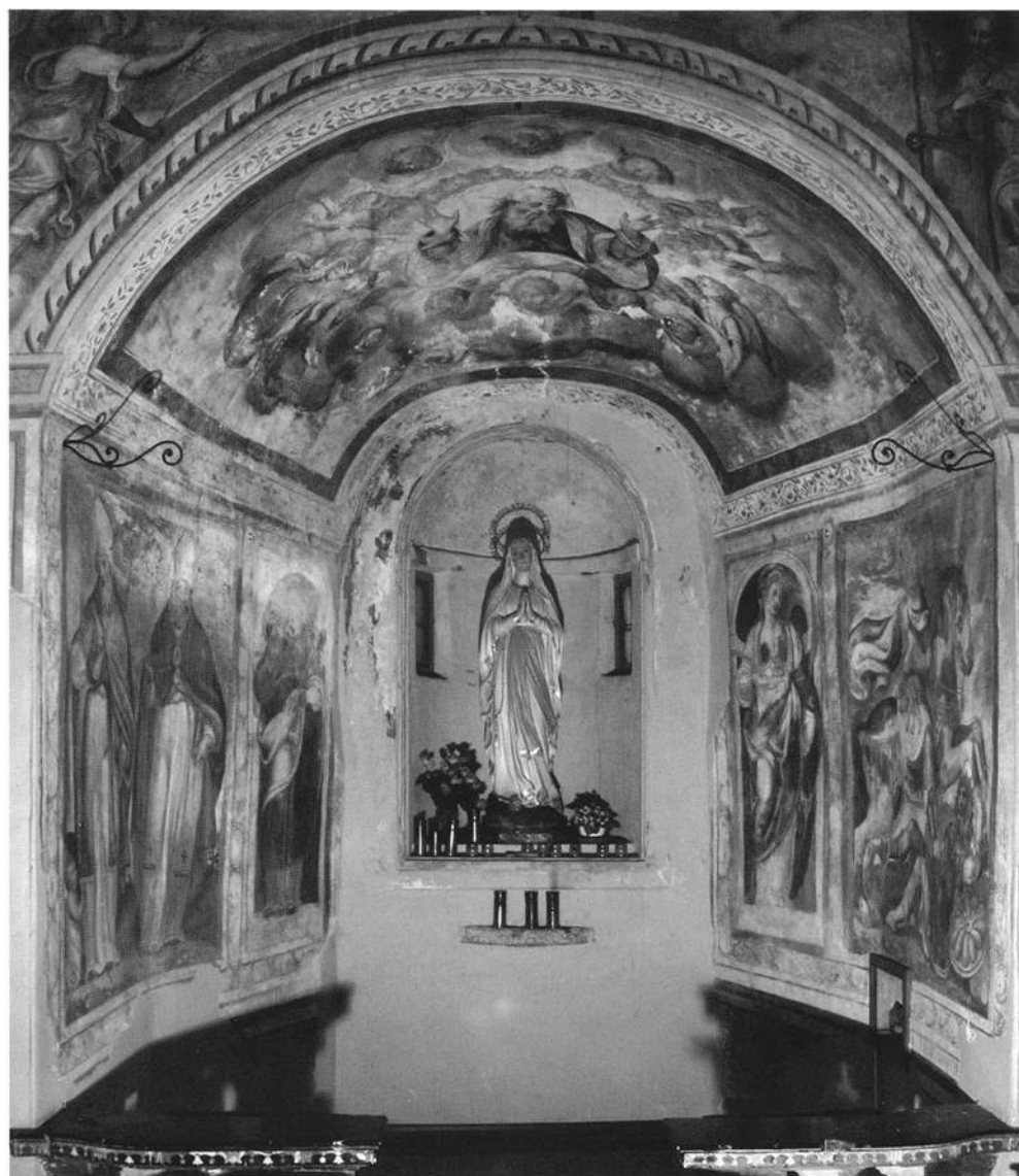
Fig. 46 – La cappella della Vergine prima del restauro.
