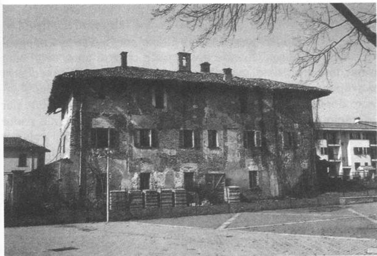
La casa del Fittabile - Ponte Sesto
