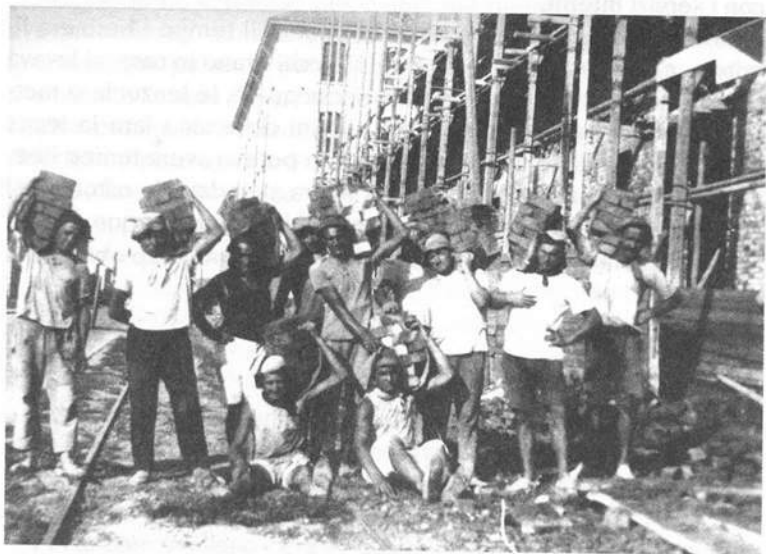
1925. Costruzione delle case operaie sulla strada pavese
