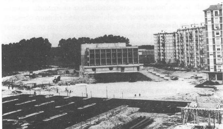
Il nuovo Municipio in costruzione, fine anni '60
