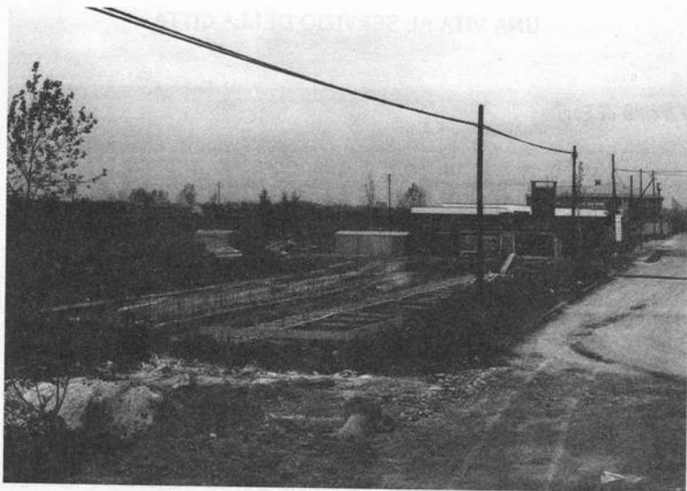
Ottobre 1970. Inizio dei lavori per la costruzione della scuola di Valleambrosia
