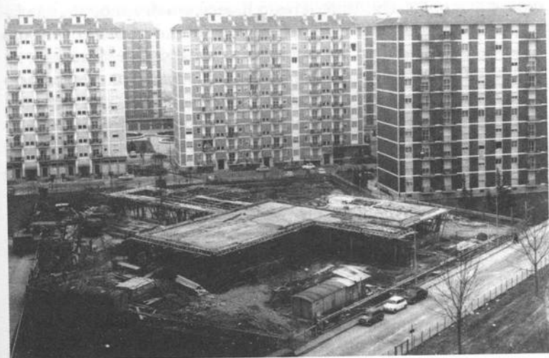
1970. Costruzione dell'asilo nido di via Magnolie nel quartiere IACP.
